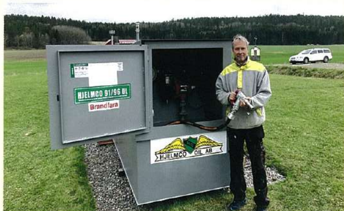
Trosa Flygklubb: April 2018. Ny motordriven tank om 3 m 3 med Hjelmco AVGAS 91/96 UL
